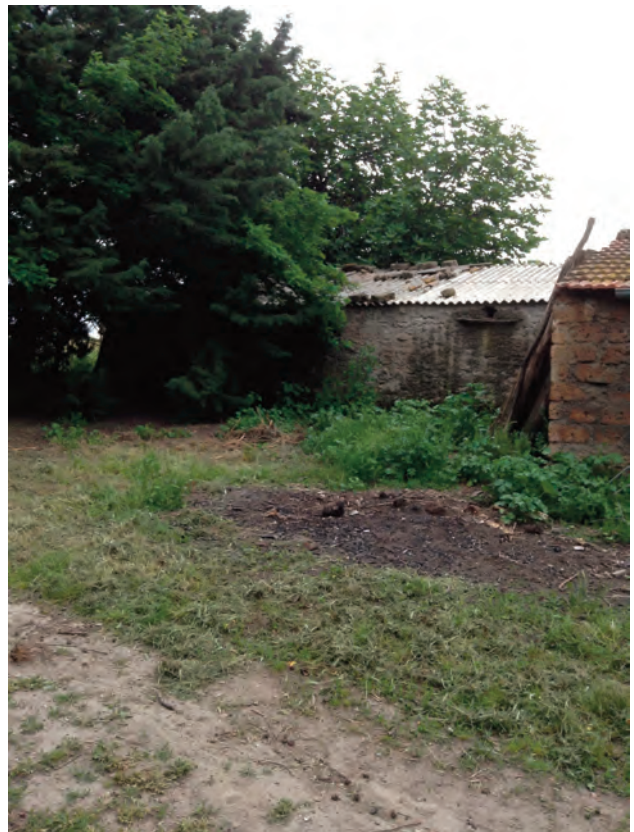
unità edilizia: E 169E3
