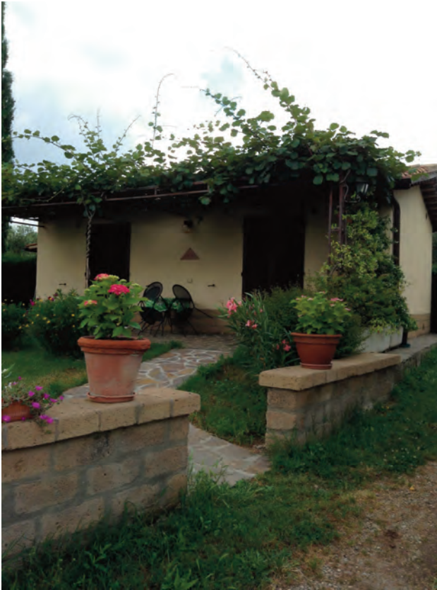
unità edilizia: E 162E1
