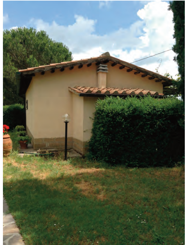
unità edilizia: E 162E2
