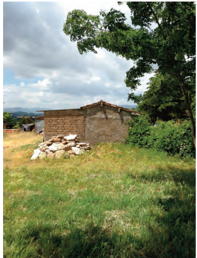
unità edilizia: E 165E4
