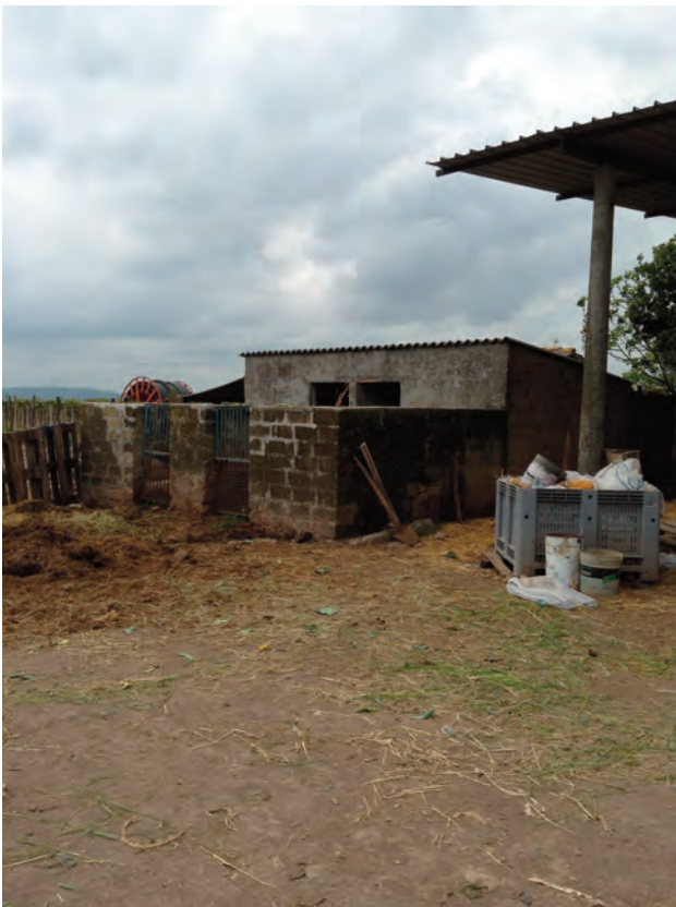
unità edilizia: E 147E1
