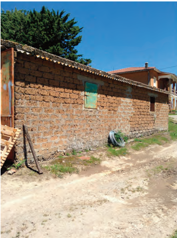
unità edilizia: E 171E2
