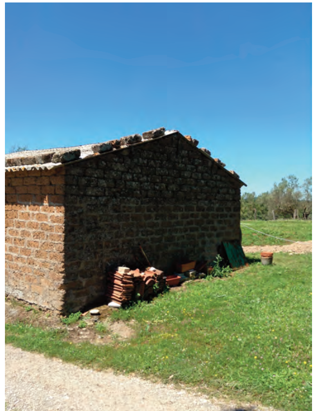
unità edilizia: E 171E3
