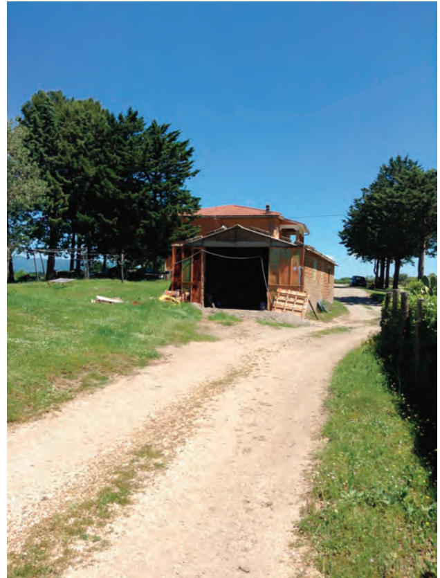
unità edilizia: E 171E1
