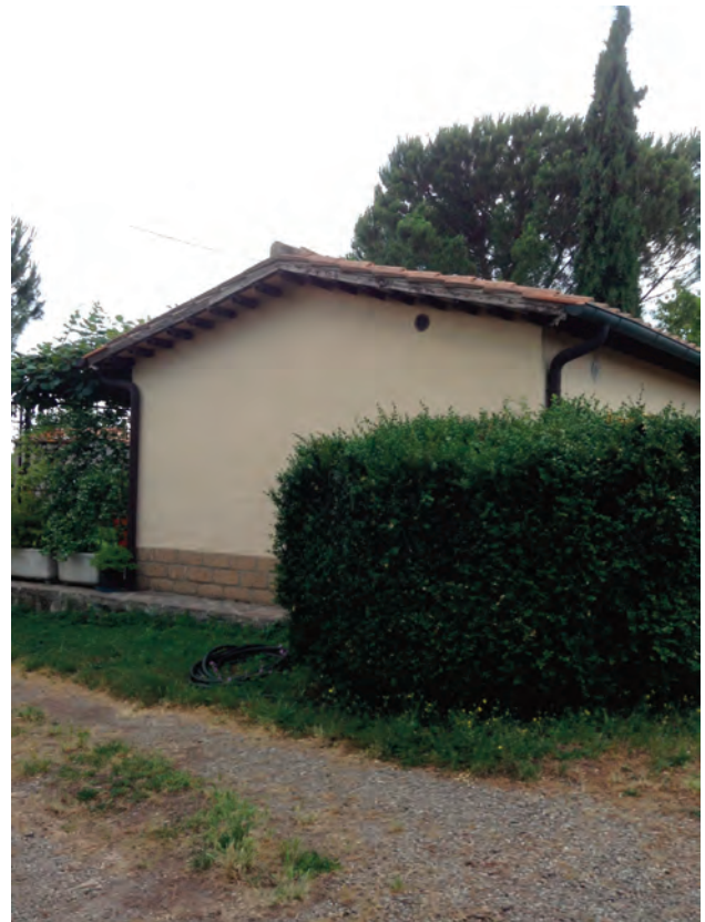
unità edilizia: E 162E4
