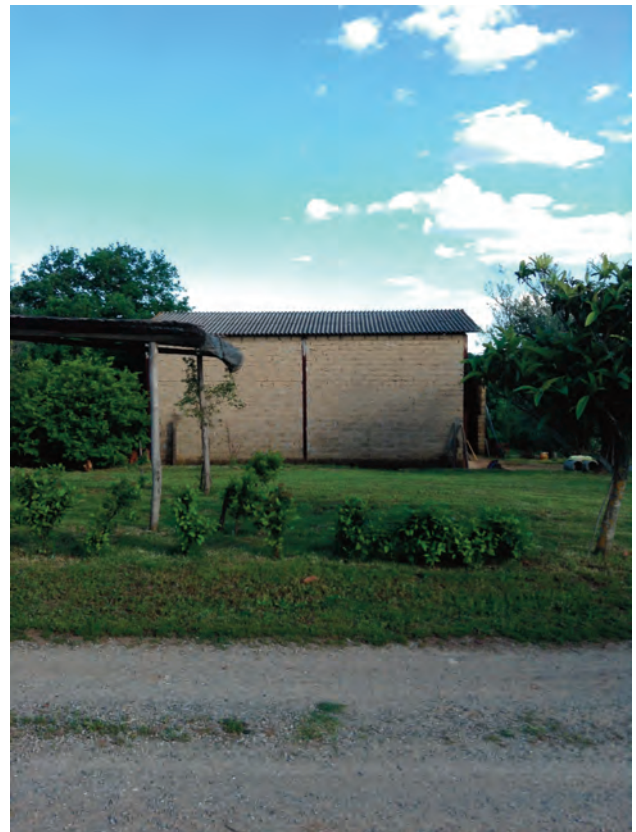
unità edilizia: E 143E2
