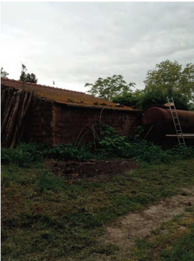
unità edilizia: E 169E2
