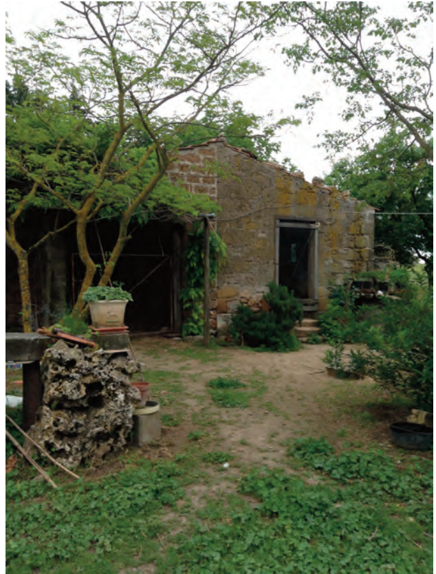
unità edilizia: E 169E1
