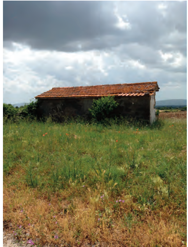
unità edilizia: E 165E2
