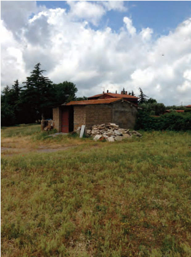
unità edilizia: E 165E1
