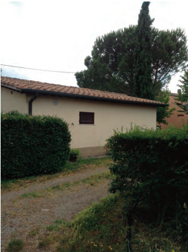
unità edilizia: E 162E3
