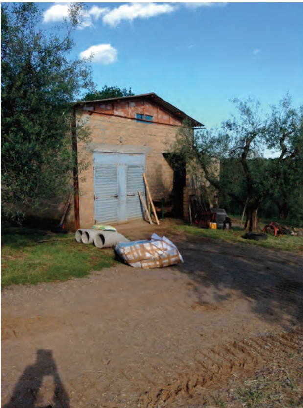
unità edilizia: E 143E1
